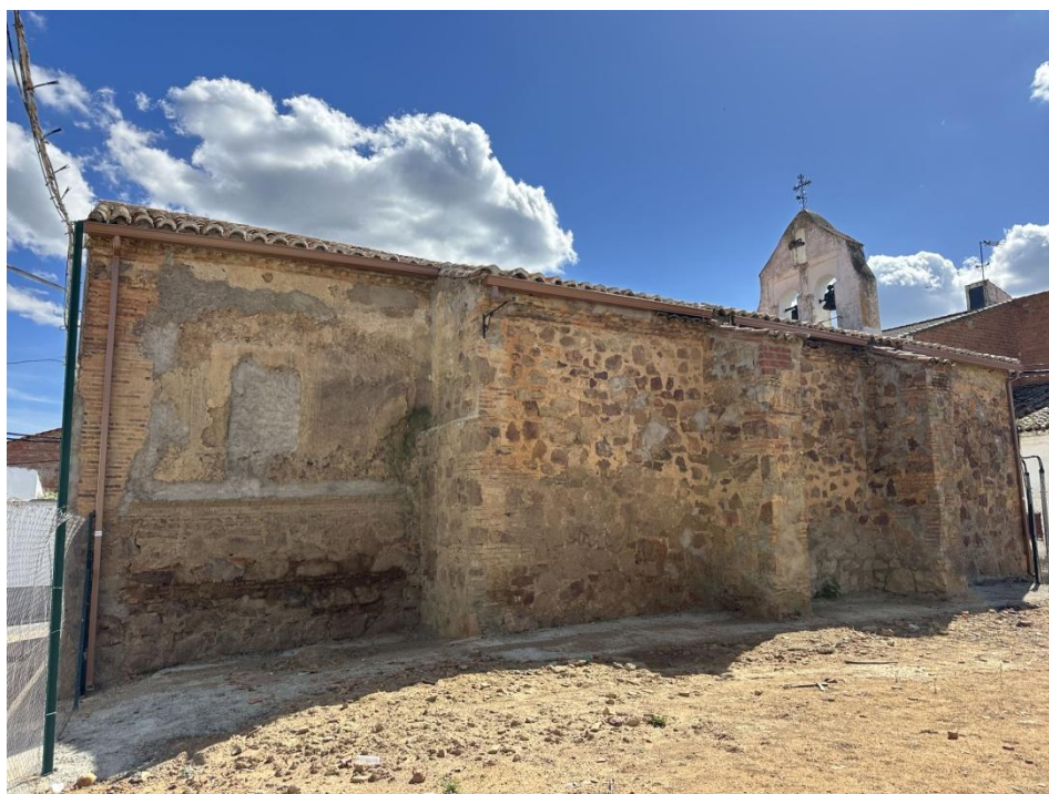
Vista lateral que muestra la pared en piedra. © ARZOBISPADO DE TOLEDO. TOLEDO. ESPAÑA
