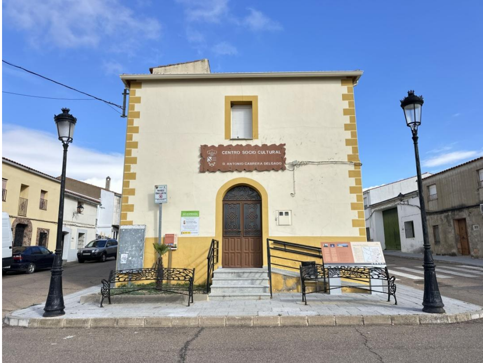
Centro Socio Cultural Antonio Cabrera Delgado, donde se encuentra la capilla.
