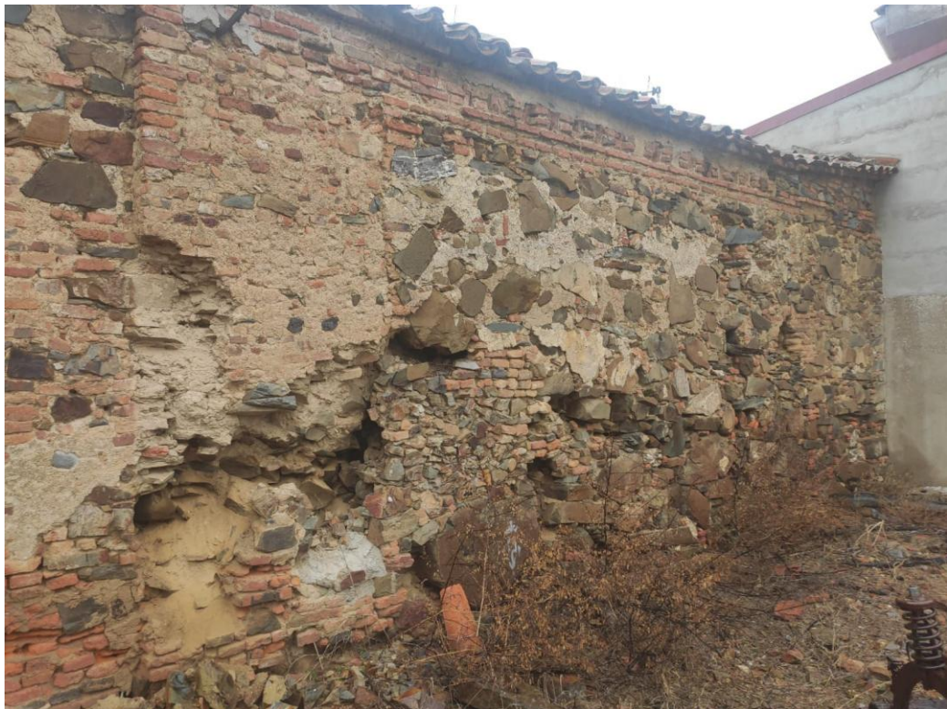
Restos de uno de los muros de carga de la antigua ermita.
