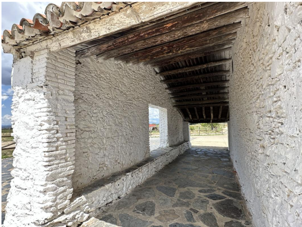
Pórtico sustentado por pilares de ladrillo.
