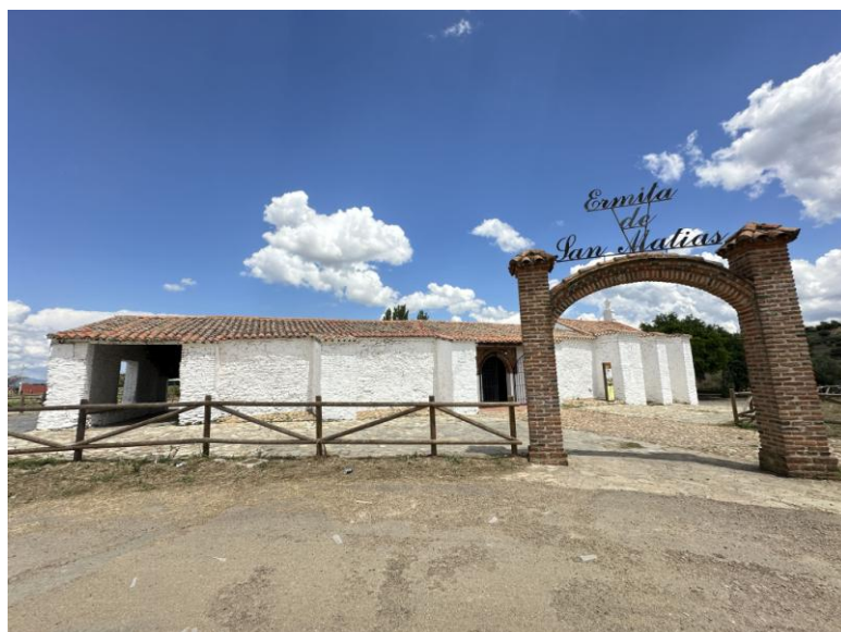
Vista exterior de la ermita.
