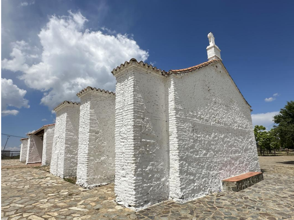
Contrafuertes en uno de los costados de la ermita.
