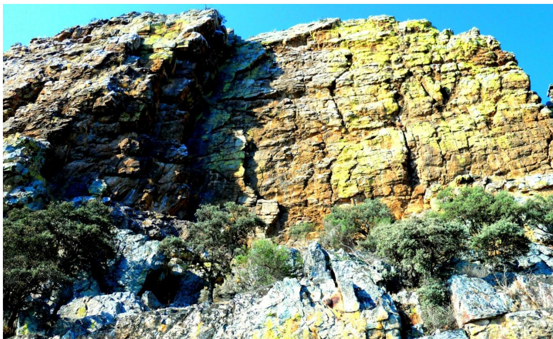
La vegetación, el aislamiento del enclave y el paso del tiempo han favorecido su deterioro. FOTOS: JOSÉ ANTONIO BERMEJO.
