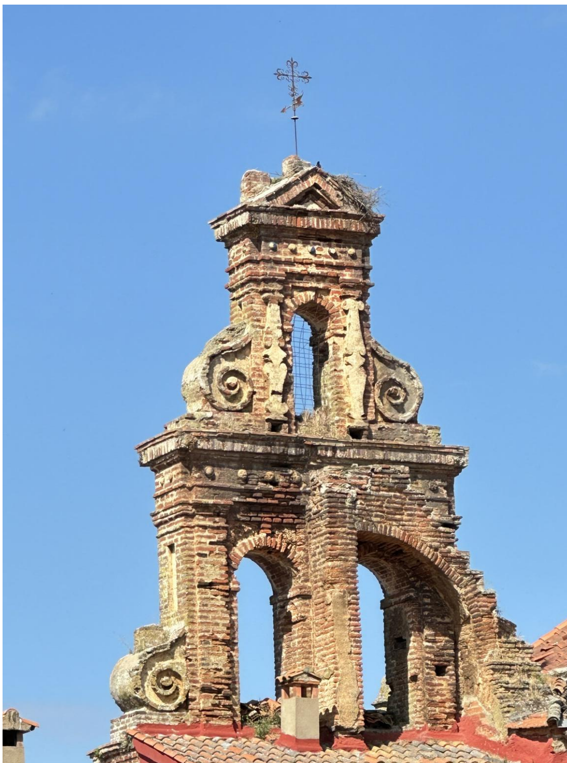
Espadaña del convento, desprovista de campanas.
