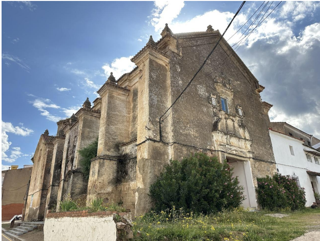
Vista exterior del convento.
