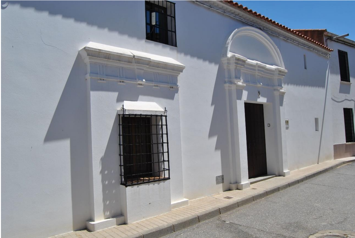
Imagen de la Casa de Castro.
