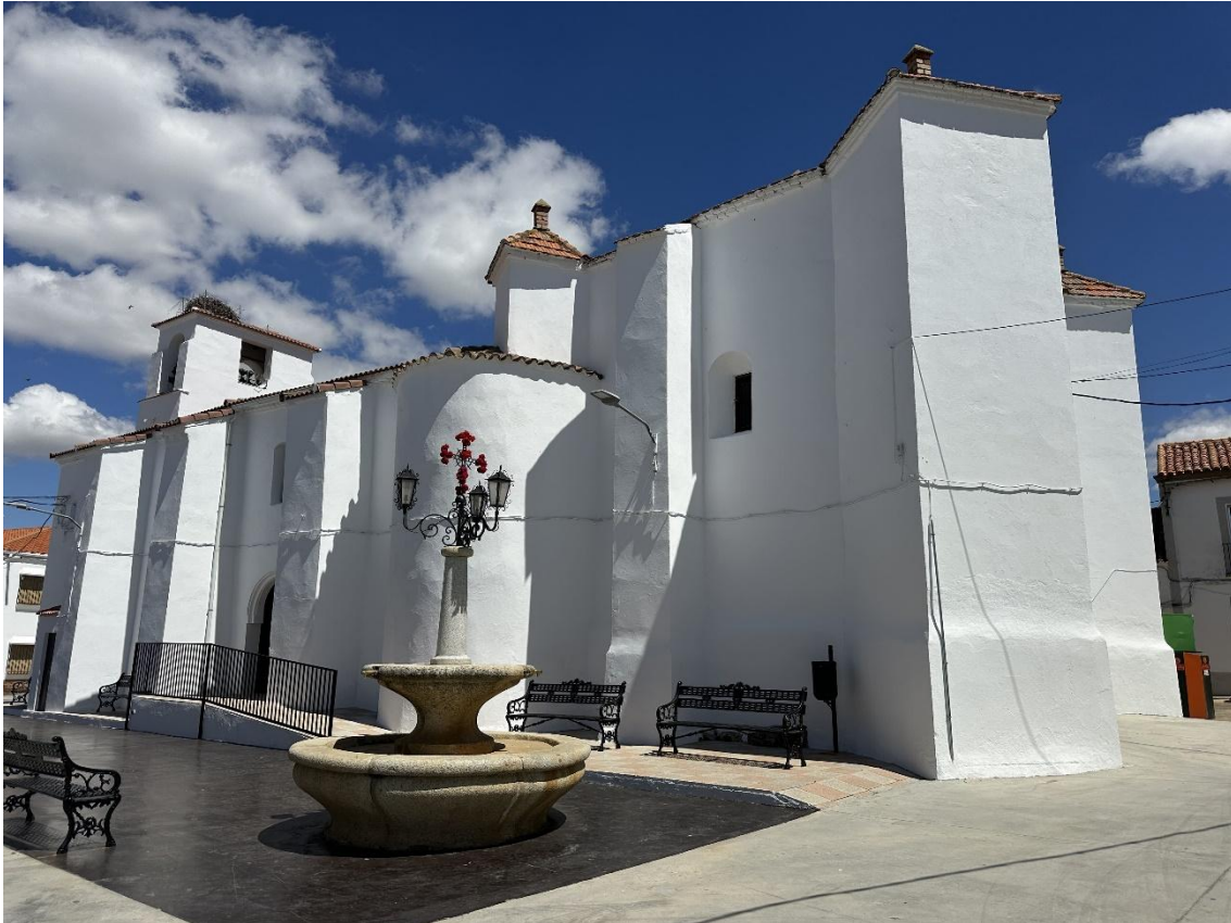
Contrafuertes laterales de la nave, coronados por pináculos de ladrillo restaurados.
