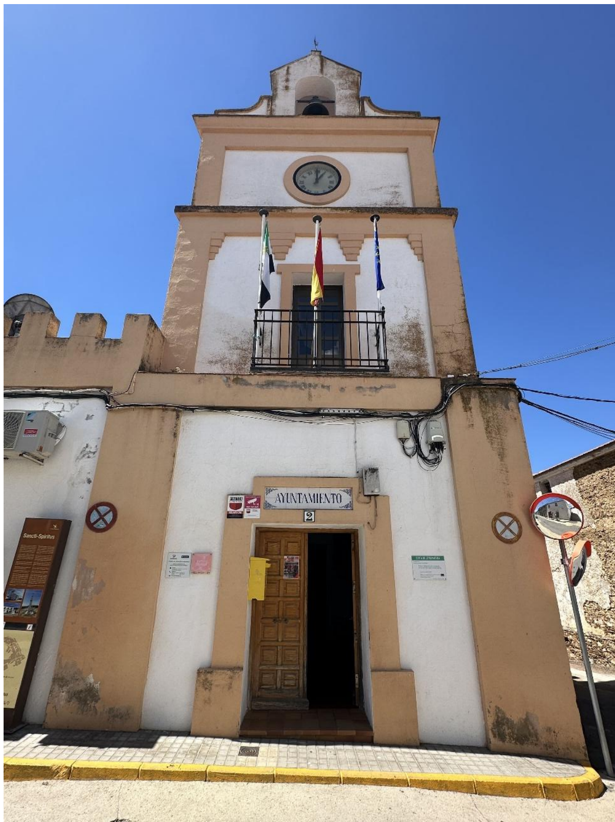
Edificio del ayuntamiento.
