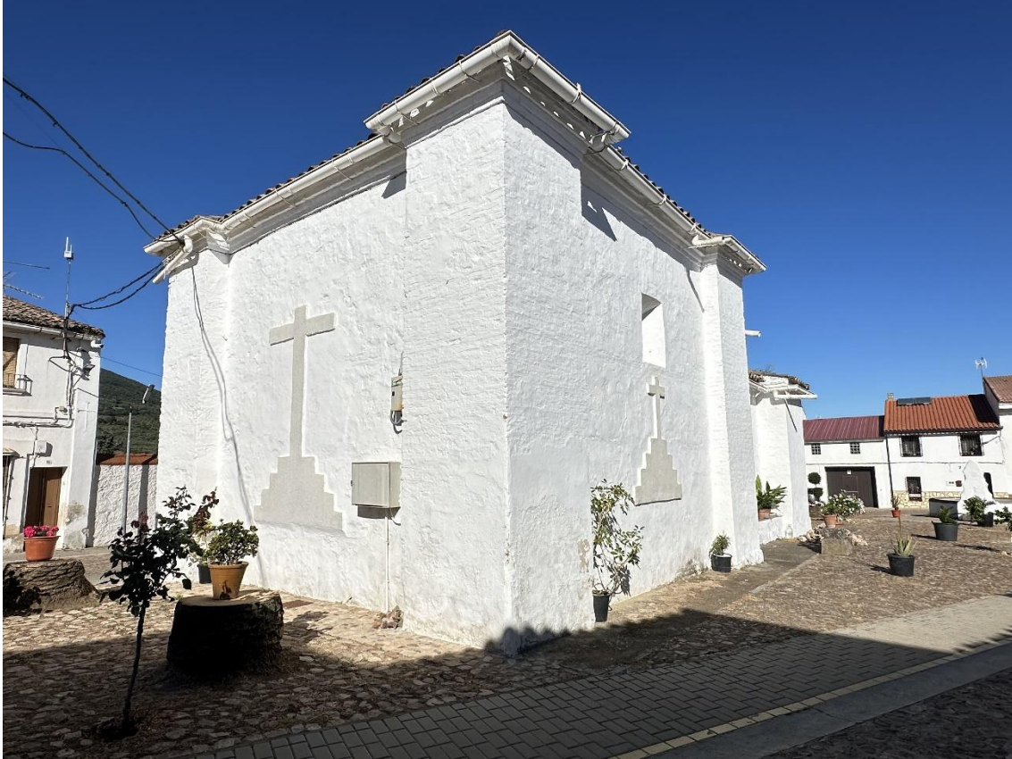
Detalle de las cruces de gran tamaño en la pared lateral y trasera de la ermita. © ARZOBISPADO DE TOLEDO. TOLEDO. ESPAÑA
