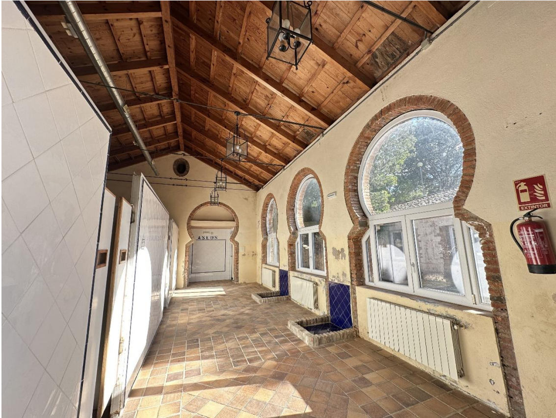
Interior de las instalaciones, bien conservadas pese a encontrarse cerrado.
