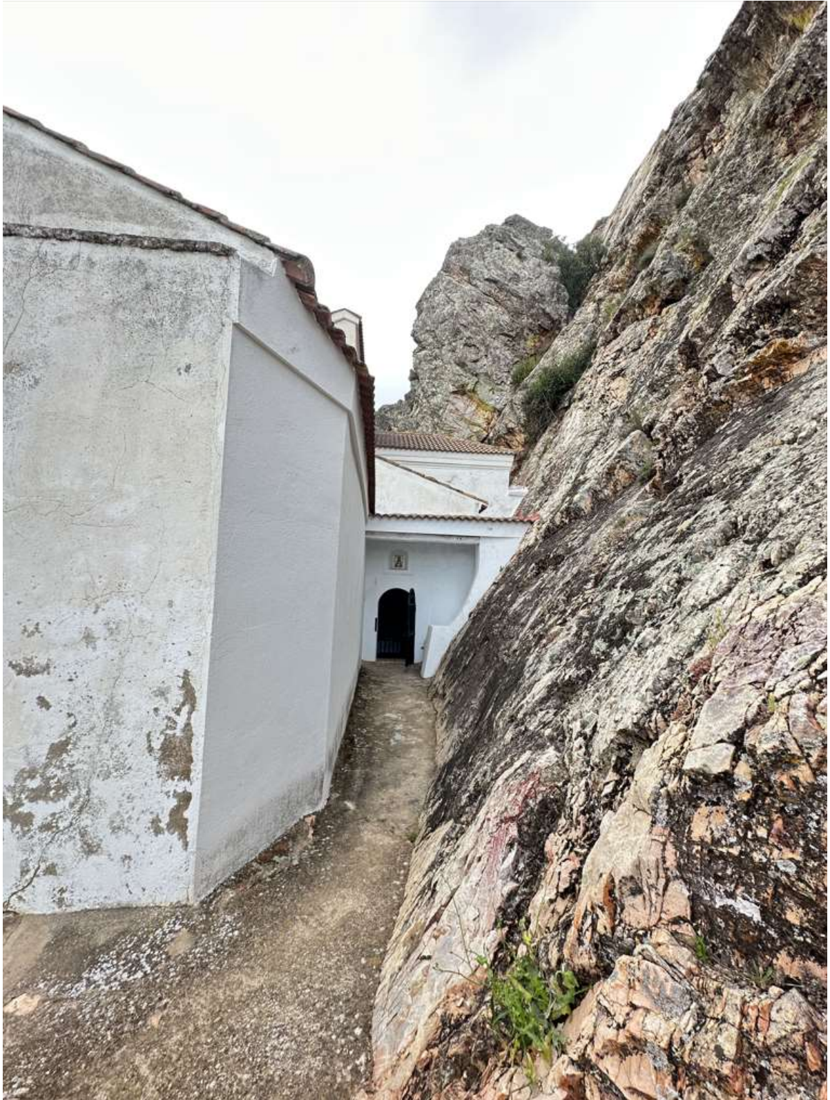
Puerta de acceso desde la carretera del castillo de Puebla de Alcocer.
